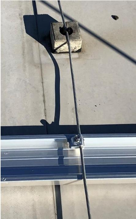
Detail E: Lösungsvariante: bestehender Blitzschutz wird so belassen bzw. wieder vollständig aufgebaut und die PV-Anlage wird angeschlossen (VK)
