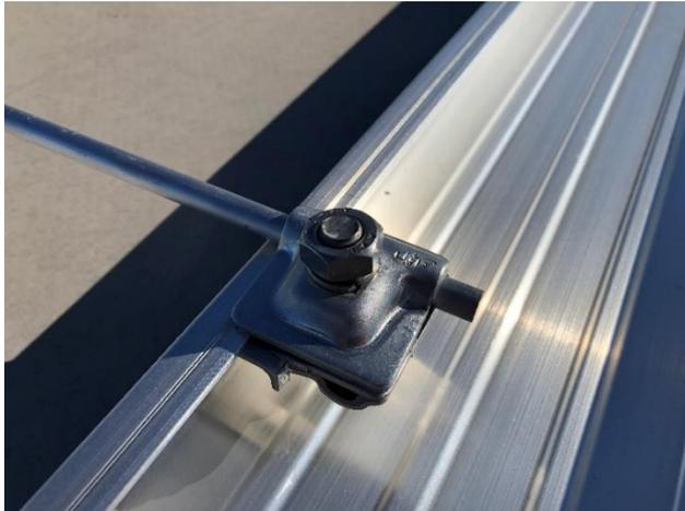
Detail A1: Anbindung Runddraht an die Grundschiene (MK)
