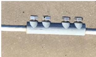
Detail D: Erneuter Anschluss von durchtrennten Runddrähten mittels Stoßverbinder. Dies kann alternativ auch mit MK ausgeführt werden (nicht dargestellt)
