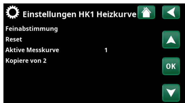
Menü „Fachmann/Einstellungen/Heizkreis/Heizkreis 1/Heizkurve“. Aktive Messkurve: #1.
